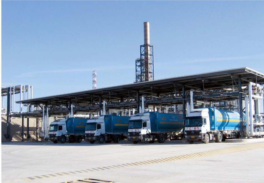
Capacidad del sistema está diseñado para llenar 100 camiones o contenedores dentro de 16 horas y consiste de seis estaciones de carga de contenedores (fijas en los coches de la plataforma ferroviaria) y cuatro estaciones de carga para camiones.
